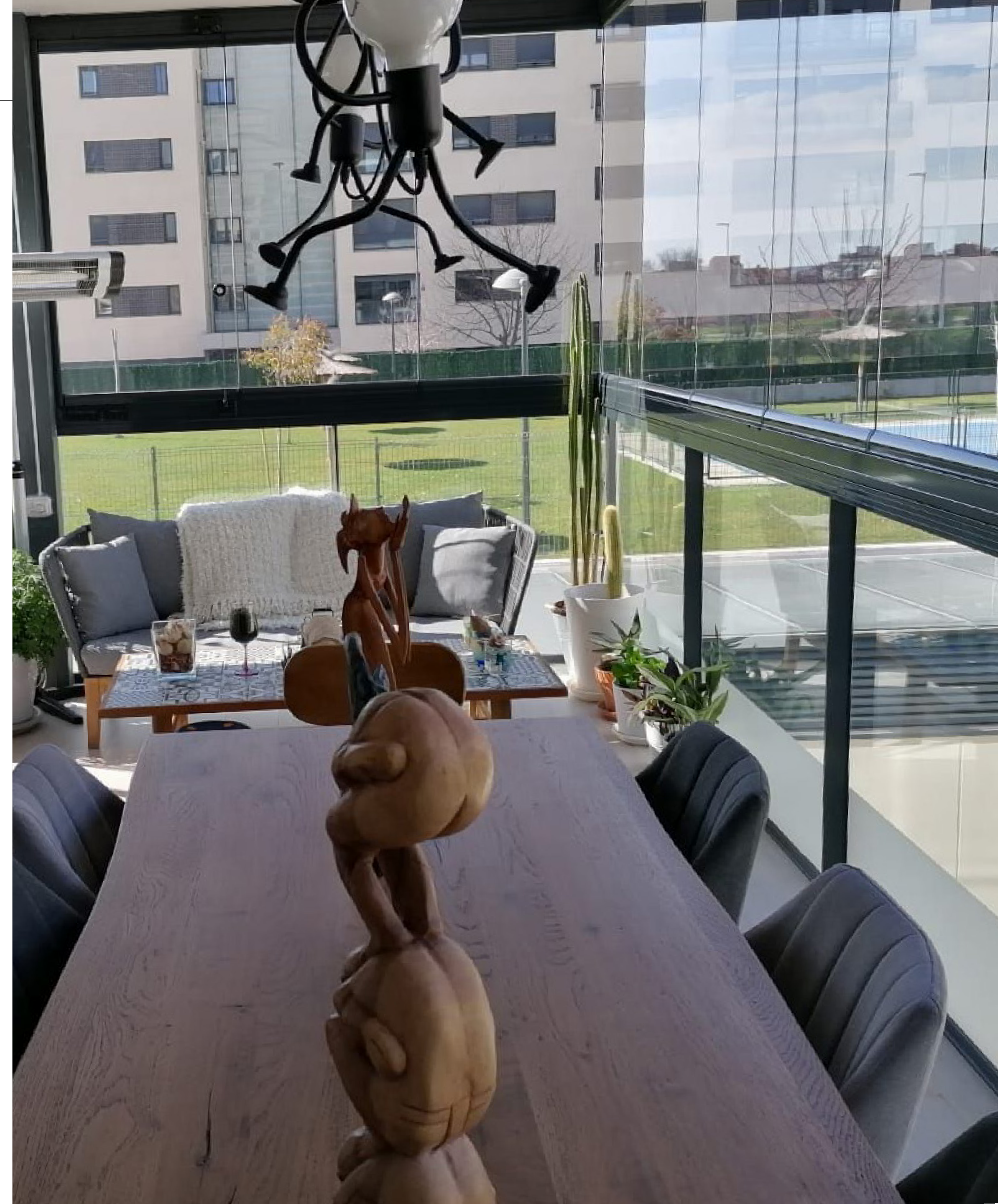
Sistem cu 7 laturi și unghi de 135° urmează forma rotunjită a balconului
